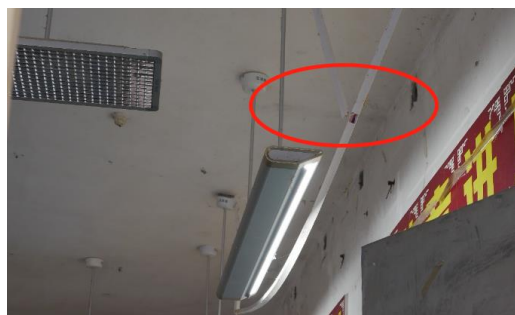
图3 线槽脱落
